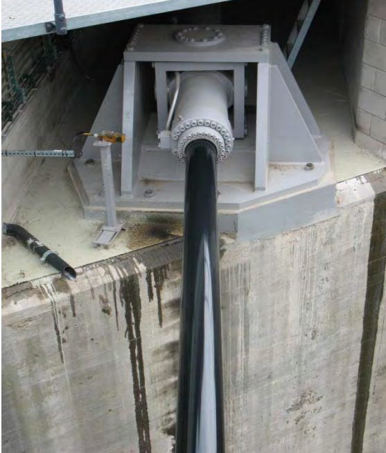
Fig. 17: Cardanic support of cylinder, Bernhardsluis, Wijk bij Duurstede, Netherlands
